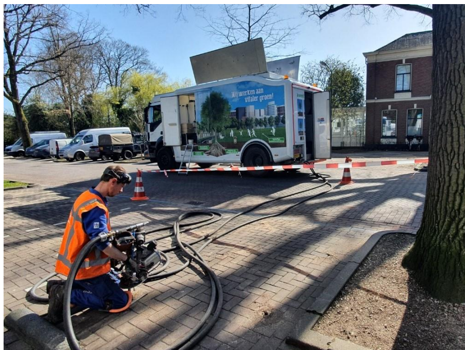
Figuur 1 Inbrengen inspuitlans bij een parkeerplaats ter vermindering wortelopdruk
