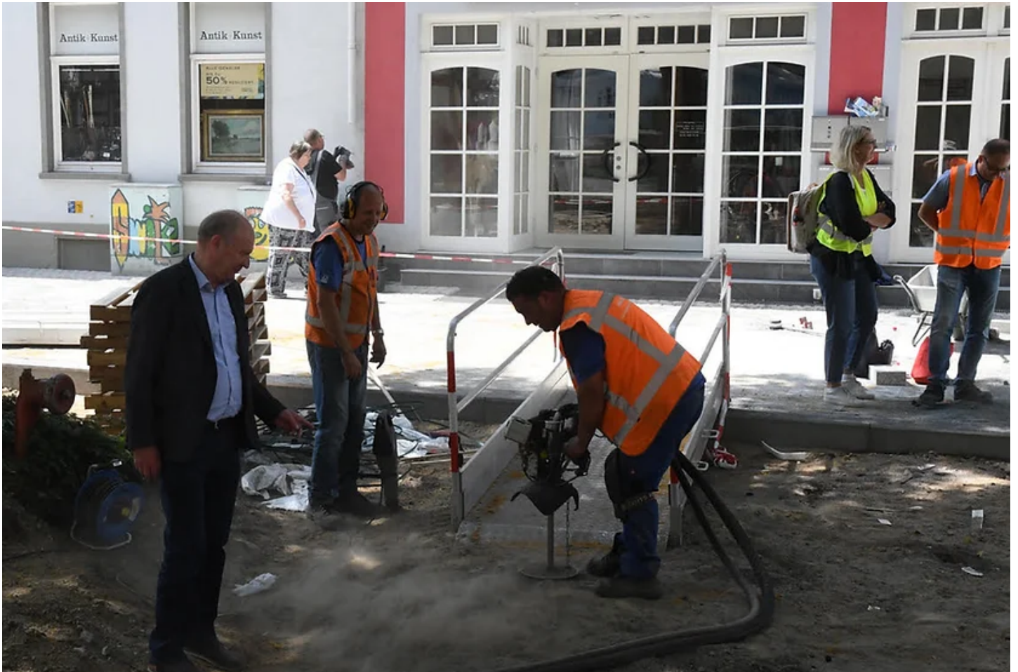
Umfangreiche Baumpflegemaßnahmen auf dem Brandplatz Fotos: Peter Müller
